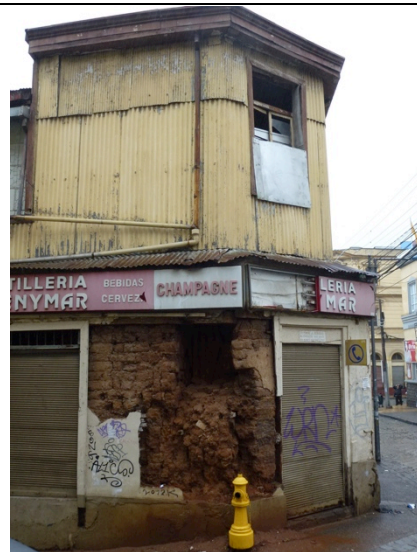
Imagen 43. Construcción en adobe, modesta y contextual, situada en la parte baja de la Plaza de La Matriz, dentro del Sitio de Patrimonio Mundial; ya está autorizada su demolición total y sustitución por un edificio de nueva planta. Dicha construcción debería ser objeto de una restauración integral, lo cual es perfectamente posible desde un punto de vista técnico (06.08.2015).
