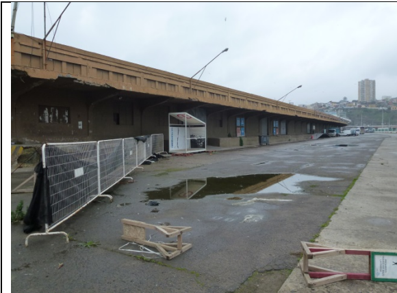
Imagen 27. Aspecto exterior de la Bodega Simón Bolívar; se aprecia el componente longitudinal del inmueble y sus aleros exteriores, que son parte integral de su estructura (05.08.2015).
