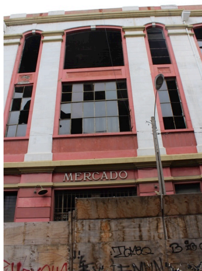
Imagen 39. Edificio del Mercado Puerto severamente afectado por el sismo de 2010. Debe recuperarse, con carácter urgente, el edificio y su uso tradicional como mercado público (06.08.2015).
