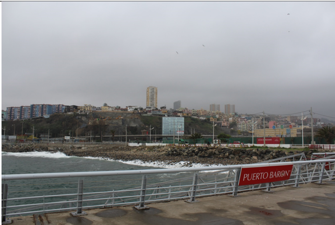
Imagen 31. Sector en donde se proyecta construir el Proyecto Puerto Barón. Nótase en la valla que Puerto Barón es una marca registrada por la Empresa Portuaria Valparaíso (05.08.2015).
