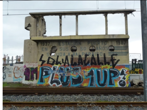
Imagen 21. Ruinas de la antigua caseta de control de la Estación Puerto de la ciudad de Valparaíso; sitio relacionado con el Área histórica de la ciudad puerto de Valparaíso que amerita una valoración y protección patrimonial, así como una restauración integral. (09.09.2015)
