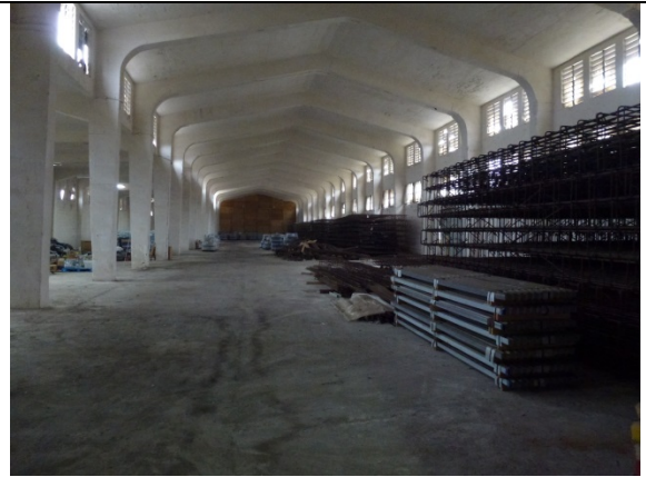
Imagen 26. Vista interior de la Bodega Simón Bolívar en donde se puede apreciar su estructura compuesta por marcos tri articulados (05.08.2015).
