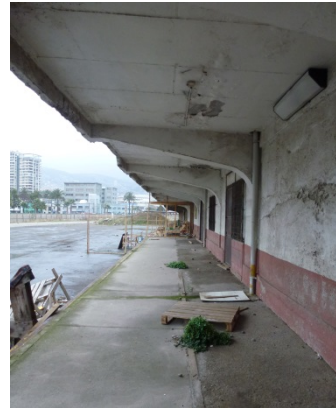
Imagen 28. Aspecto exterior de la Bodega Simón Bolívar; se aprecia el componente longitudinal del inmueble y sus aleros exteriores, que son parte integral de su estructura (05.08.2015).
